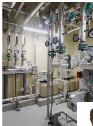
←機械室内配管の様子。大型のボイラーをはじめ、給水、暖房の温水配管や換気ダクトがびっしりときれいに設置・配管されていました。担当スタッフお疲れさまでした。
