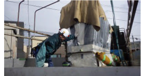
屋上のチラー搬入と機械室にボイラー他……
