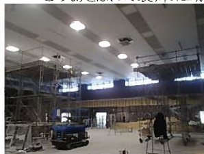
← 2階大講堂の様子です。天井の器具取付まで完了しています。このあとは、鋼製床組が開始されるようです。
